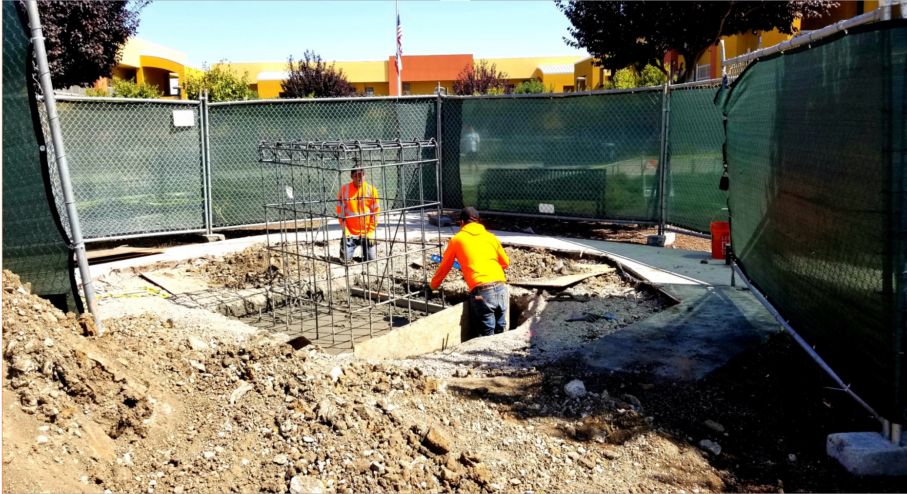
Concrete Pour of Footing Pedestal
