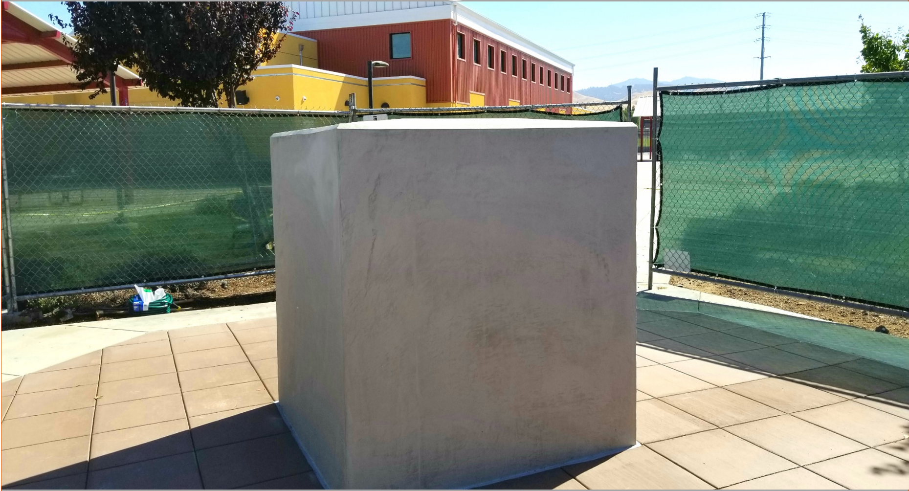
Concrete Pour of Pedestal
